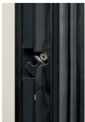
Der Verschluss mit pferdekopfförmiger Verriegelung im Rahmen
